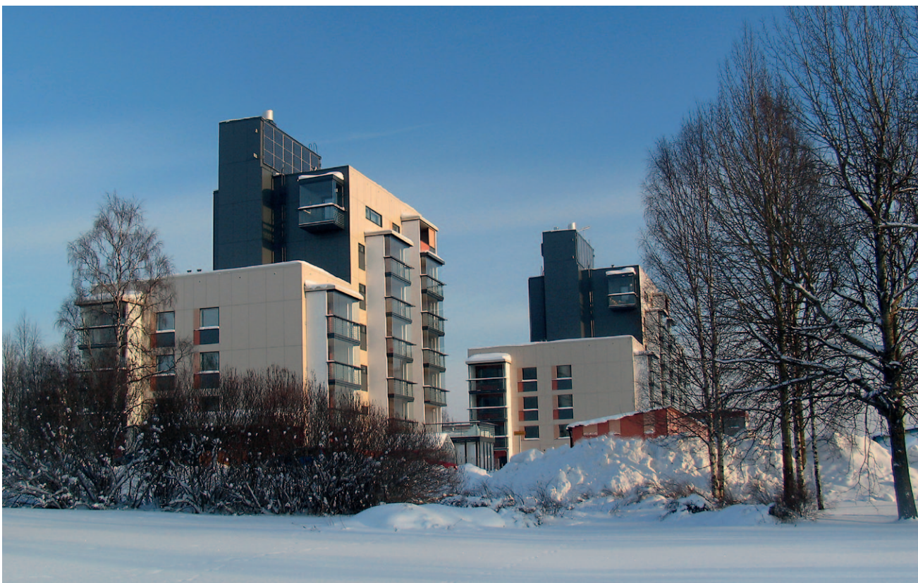
Kerrostalot muutosten jälkeen vuonna 2011. Katoille on asentamatta tuuliturbiinit.
