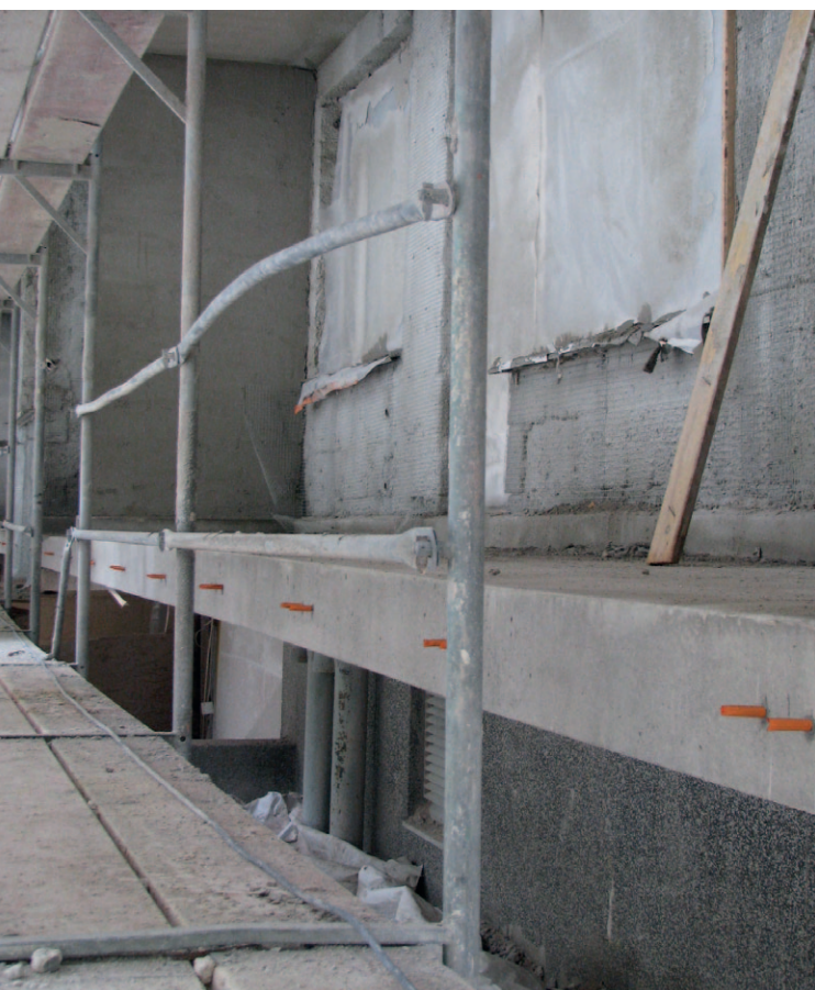
Julkisivujen energiatehokkuuden parantamiseen on yleisesti käytetty ns. lämpörappausta.
