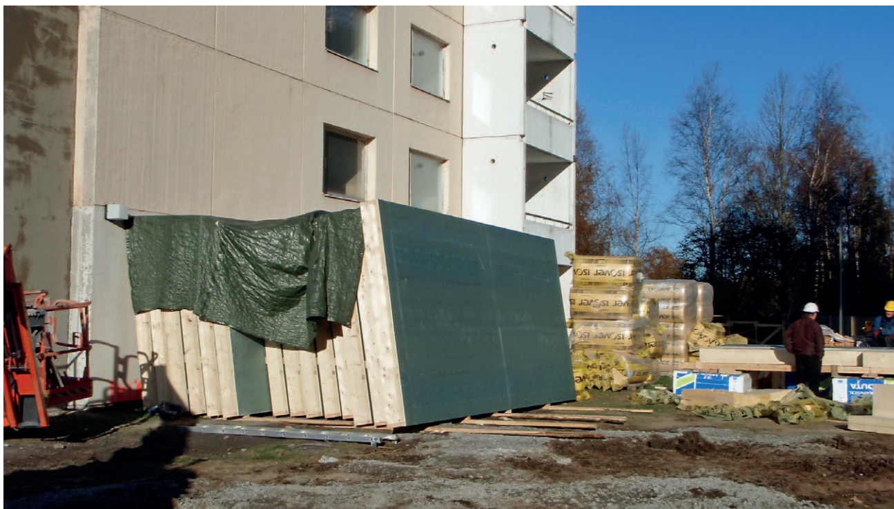
Elementtien valmistusta työmaalla. Myös puurakenteiset vesikattoelementit rakennettiin maantasossa ja nostettiin paikoilleen torninosturilla. Elementtien koko oli noin 60 m 2 ja kermi asennettiin vasta ylösnoston jälkeen.
