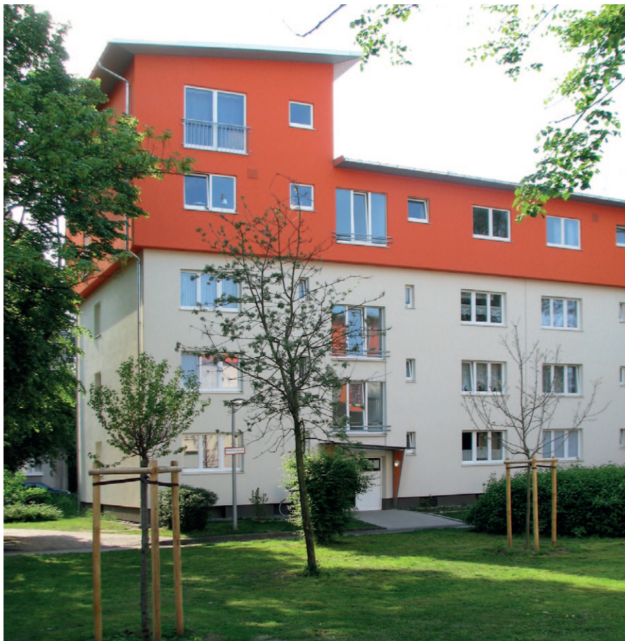
Köln. Korjaus- ja lisärakentamista Ford:n asuntoalueella.
