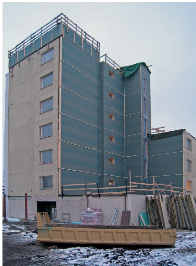
Elementit asennettuna seinään, tuulensuojalevyn päälle asennettiin pystykoolaus (tuuletusrako) ja julkisivun kompaktilaminaattilevy.
