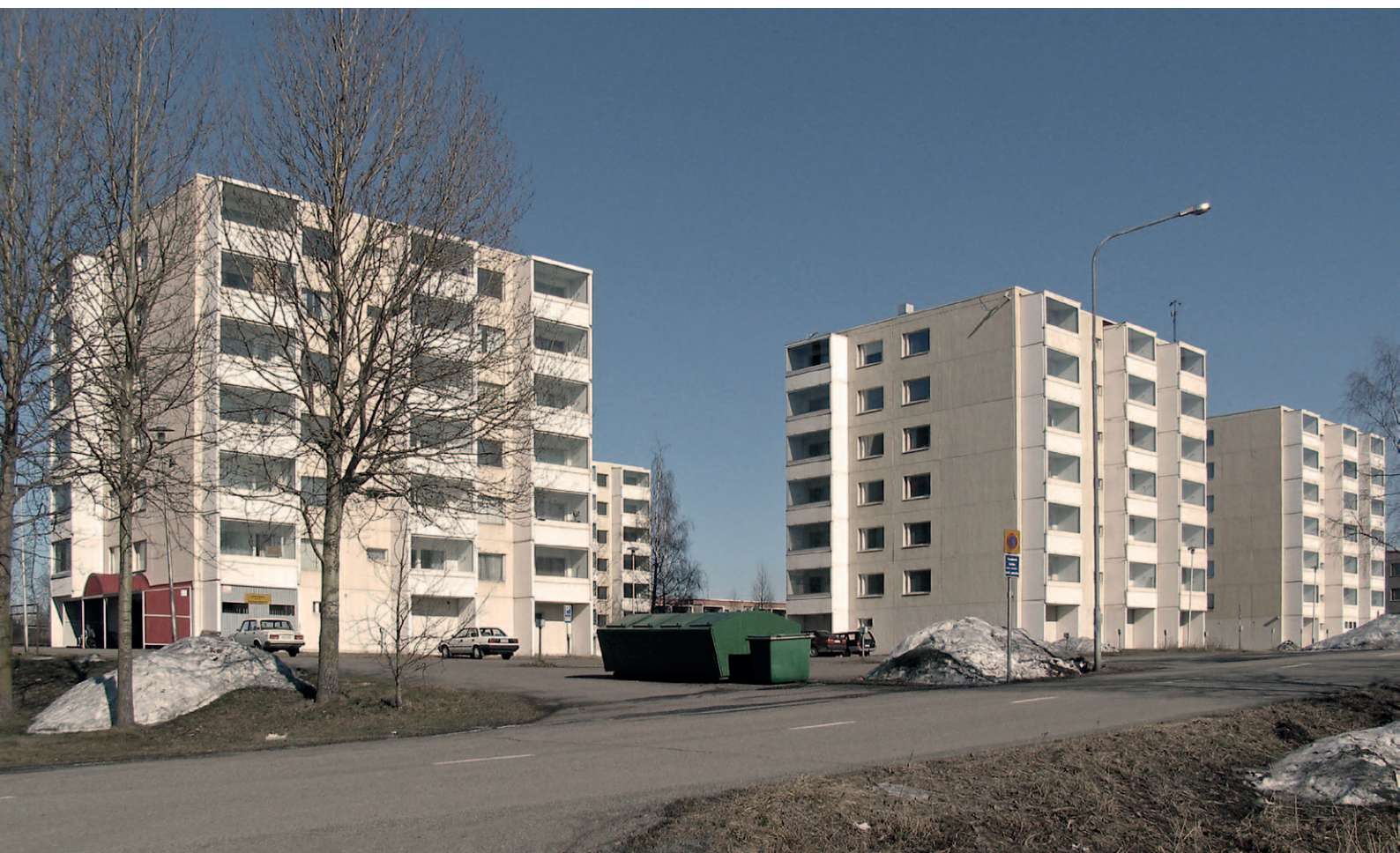
Ratsukadun kerrostaloja vuonna 2009 ennen purkutöitä ja korjauksia.
