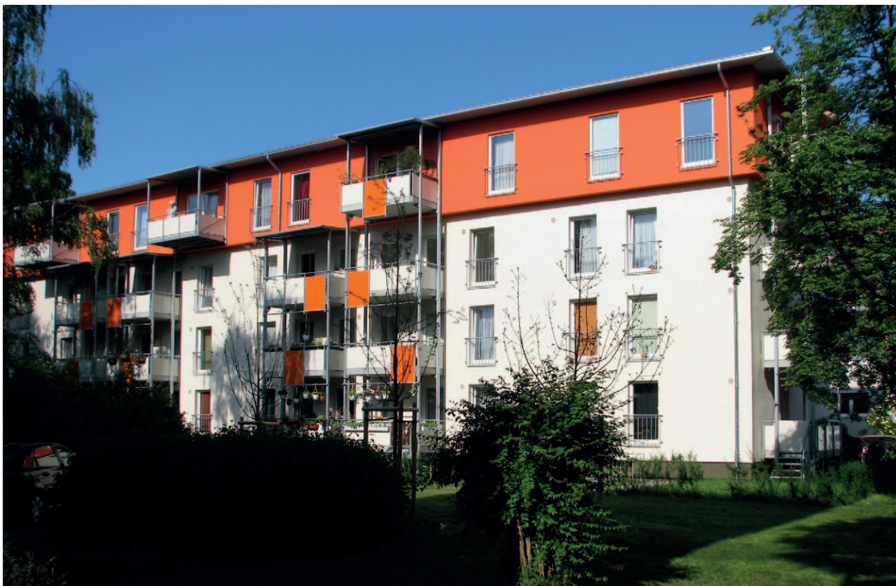
Rakennuksiin on lisätty kerroksia, ulkoseiniin tehokas lämmöneristys ja asuntoihin parvekkeet.
