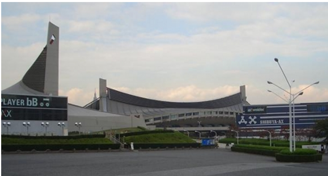
Kuva 2: Yoyogi National Gymnasium, Yoyogin puistossa Tokiossa sijaitsevat urheiluhallit riippukattoineen. Kuva Juha Saunavaara.
