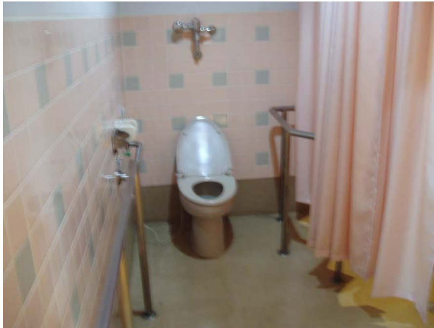
Kuva 16. Verhoilla erotellut WC ja pesutilat
