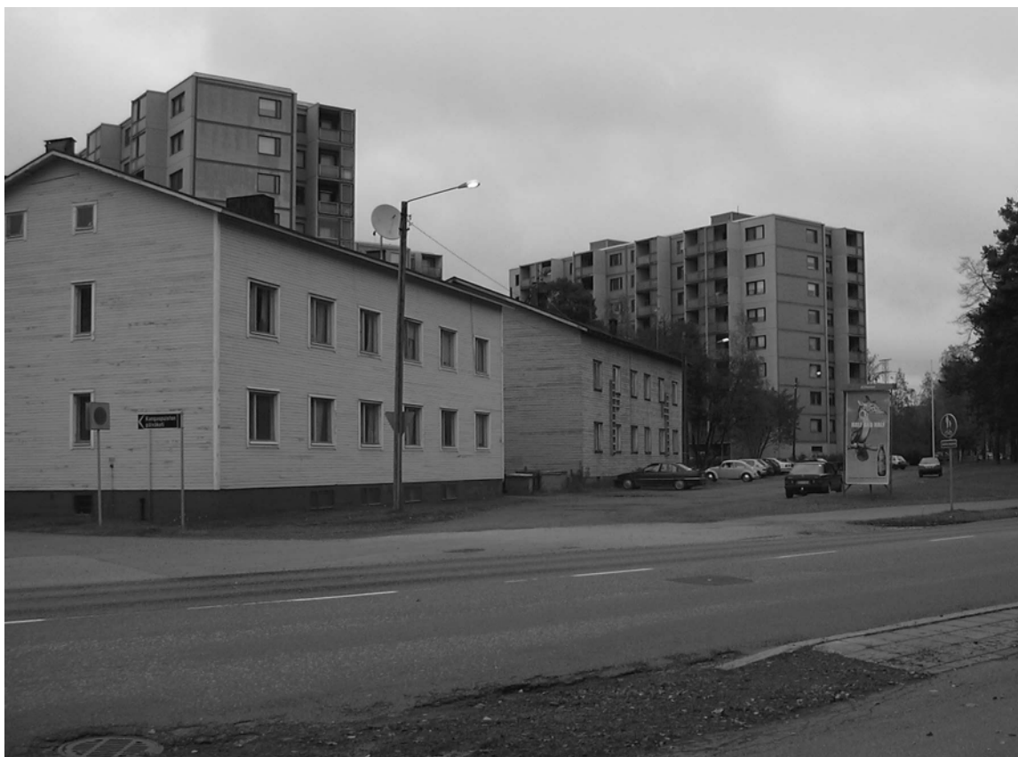
ruma paikka: Tuirantien huonokuntoiset puutalot
