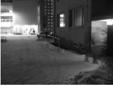
Kuva 66. Sisäänkäyntien ja yleensä ulkoalueiden valaistusta on kehitettävä, As. Oy Uusi-Heikki.
