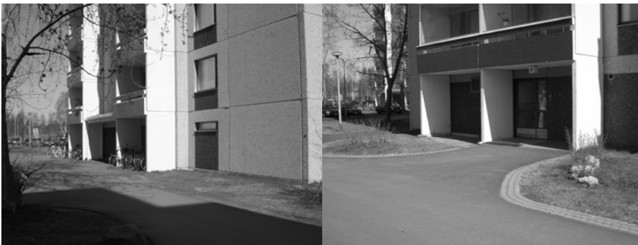
Kuva 61. Sisäänkäynti ei hahmotu. Kiint. Oy Länsitorni.
