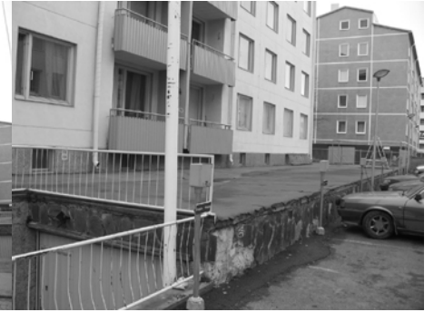
Asfaltoitu käyttämätön kansipiha
