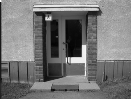
Sisäänkäynti kadun puolelta
