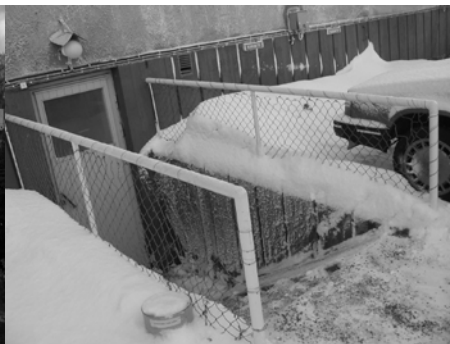
Sisäänkäynti kellariin pihan puolelta talvella
