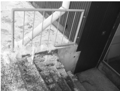
Kuva 58. Jäättyessään sadevedet muodostavat liukastumisvaaran. As. Oy Koulukatu 31.
