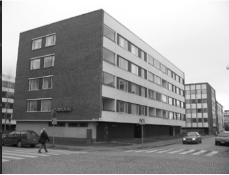
Rakennus ja piha kadun puolelta
