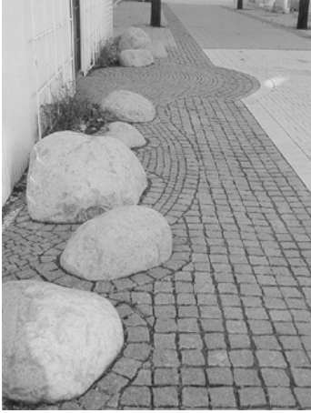
Kuva 60. Päälystepintoja sokkelin rajassa.
