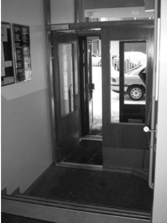
Kuva 14. Sisäänkäynti, tuulikaappi. As. Oy Tuirantorni. Kuva: Laura Sorri.
