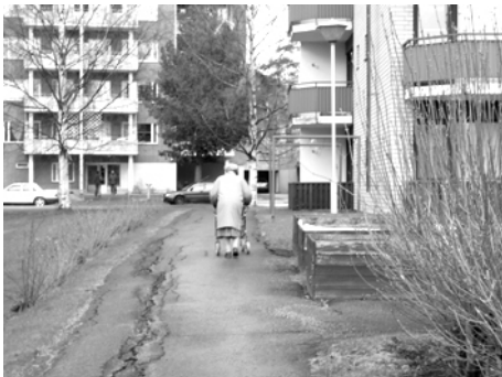
Kuva 63. Kallistunut ja vaurioitunut kulkureitti, Kiint. Oy Arvola IV.
