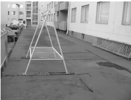
Asfaltoitu käyttämätön kansipiha
