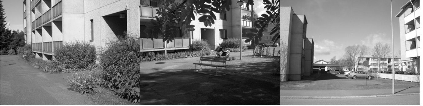
Pohjakerros ja rakennuksen viereiset istutukset
