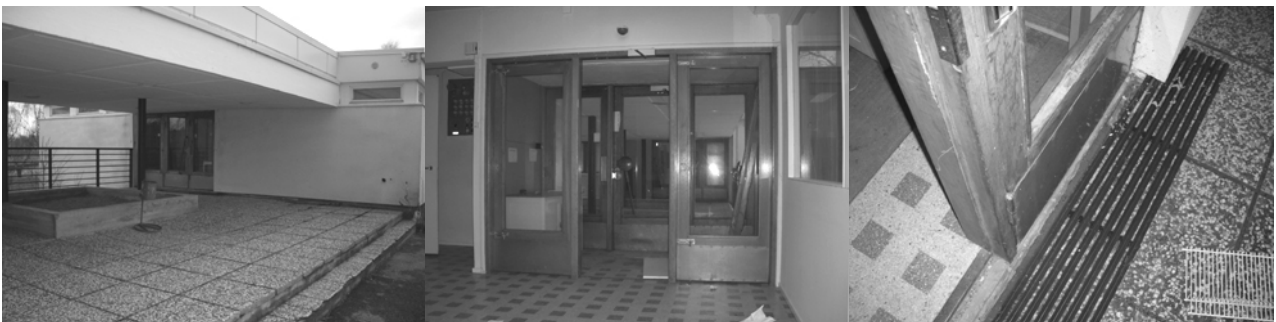
Kuva 17. Laaja katos sisäänkäynnin suojana.
