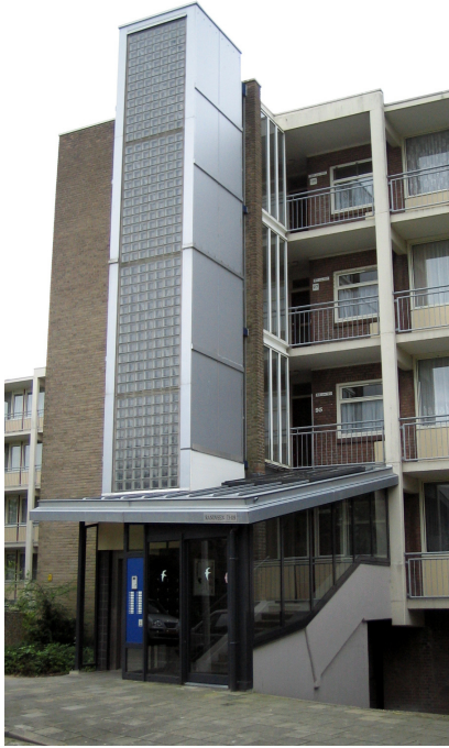
Kuva 3 (vas.). 1950-luvulla rakennettuun luhtikäytävätaloon on jälkeinpäin rakennettu hissi. Kuva 4 (oik.). Luhtikäytävän lattiaa on korotettu tarkoitusta varten kehitetyillä laatoilla. (Kuvat: Laura Sorri)
