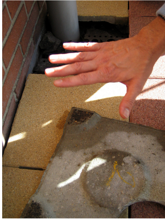
Kuva 3 (vas.). 1950-luvulla rakennettuun luhtikäytävätaloon on jälkeinpäin rakennettu hissi. Kuva 4 (oik.). Luhtikäytävän lattiaa on korotettu tarkoitusta varten kehitetyillä laatoilla. (Kuvat: Laura Sorri)
