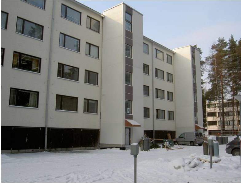
Kuva 4. Esteettömyysremontti loppusuoralla As.Oy Myllypadontie 8:ssa. (Kuva: Antti Lakka)
