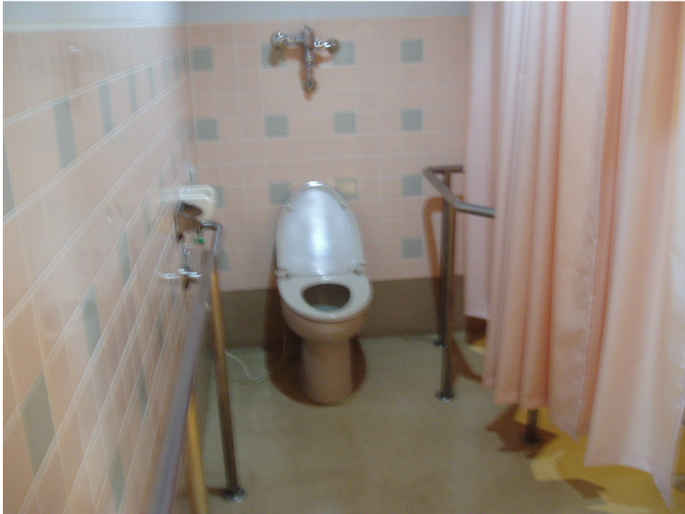
Kuva 16. Verhoilla erotellut WC ja pesutilat.
