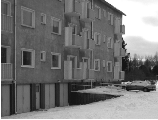
Kuva 2. Tyypillinen 1950-luvun ulokeparveke. (Kuva: Laura Sorri)
