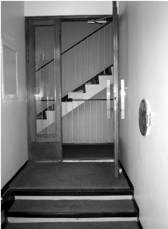
Kuva 10. Maantasokerroksen tasoeroja oli aineiston vanhimmissa, ennen 1960-luvun puoliväliä rakennetuissa kohteissa.
