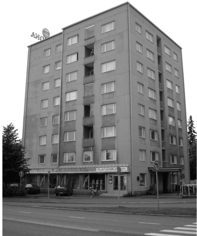
Kuva 3. Sisäänvedetyt parvekkeet 1950-luvun lopulla valmistuneessa talossa. (Kuva: Laura Sorri)
