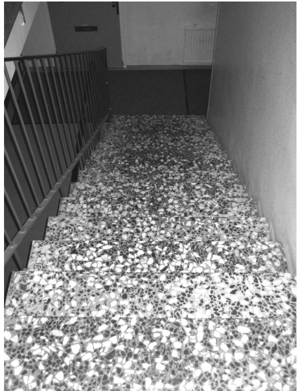
Kuva 10. Maantasokerroksen tasoeroja oli aineiston vanhimmissa, ennen 1960-luvun puoliväliä rakennetuissa kohteissa.
